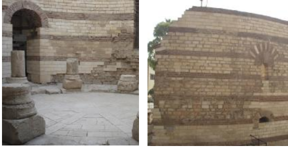
الشكل رقم (١٧). منظر عام لتبادل مداмик الحجر مع قوالب الآجر في الجدران الخارجية لحصن بابليون بالقاهرة أحد أشهر المنشآت الرومانية. تصوير الباحث
