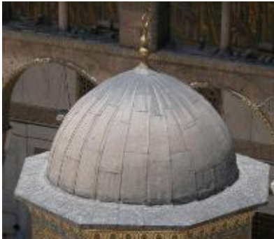
الشكل رقم (١٧). الكورنيش المثلثن يعلوه القبة المصفحة بألواح الرصاص في الجامع الأموي بدمشق ويعلوها الجمامور البرونزي. عن: Victoria and alberto collection, number 53741
